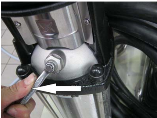
Slika 4-3: Zatvoriti vijak za odzračivanje
